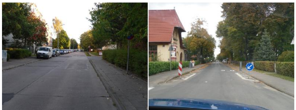
Abb. 6 Derzeitige straßenräumliche Situation – Robert-Koch-Straße (links) und Biestower Damm (rechts)
