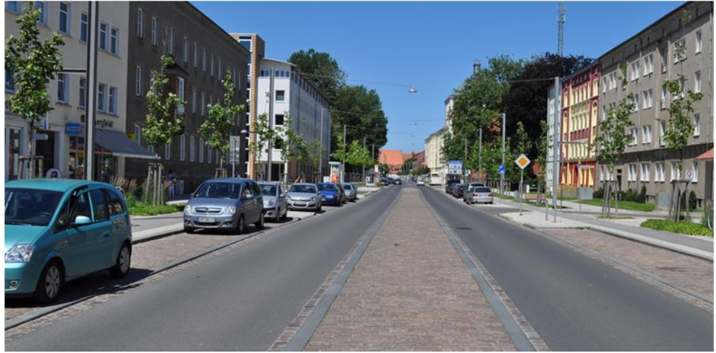
Abb. 23 Beispiel für einen dreistreifigen Straßenquerschnitt mit multifunktional nutzbarem Mittelstreifen (Stralsund)
